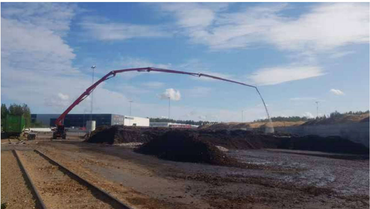
Betongpump ger stor räckvidd och precision.
